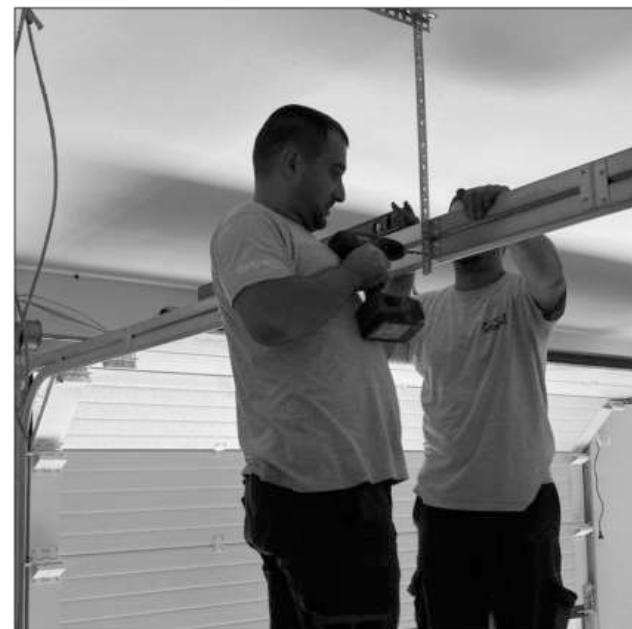
На службеној гаражи и котловници уgraђена су секциона врата, а положен је и главни инсталациони вод за спајање на водоинсталациону мрежу.
